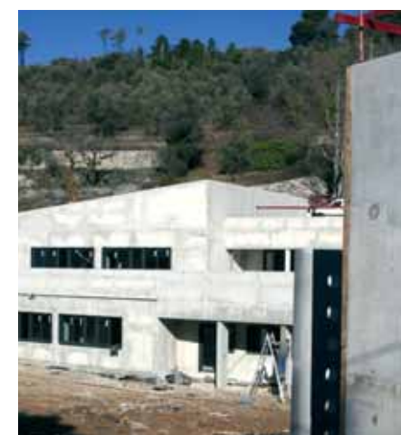
Aspremont : construction du groupe scolaire
